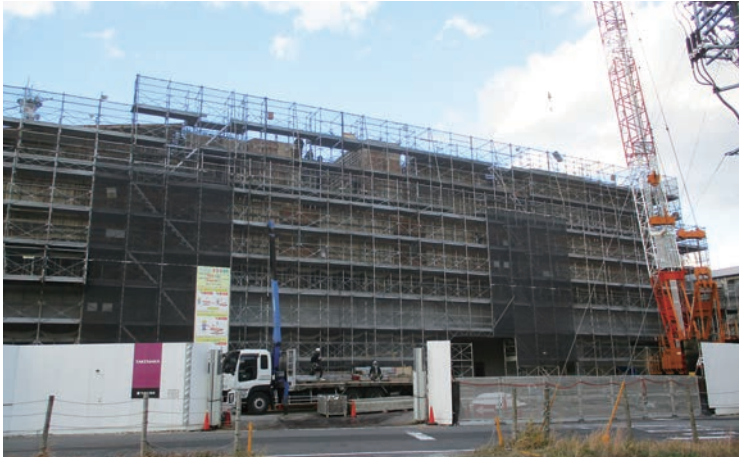
躯体工事はほぼ完了 1階から内装工事中 90tクレーンで荷揚げ作業中
